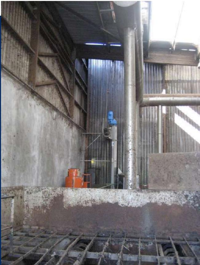
Réception des boues dans un silo sous terre. Extraction et convoyage des boues par des vis.
