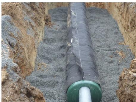
Positionner les conduites Enviro))Septic dans les tranchées dans le bon sens : Le géotextile blanc vers le bas et la couture vers le haut. Puis insérer les conduites d'alimentation d'environ 10 cm dans les conduites Enviro))Septic.
