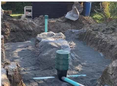
Recouvrir de sable filtrant sur une hauteur de 5 cm sur les conduites Enviro))Septic. Terminer par la pose d'une couche de remblai perméable à l'air.
