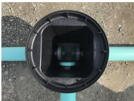
Emboîter les 4 pieds du regard et le positionner de niveau. Serrer les joints du regard puis insérer les manchons dans chacune des sorties. L'emboîtement doit être de 2 cm.
