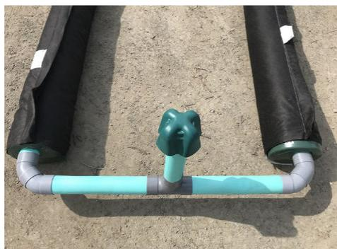
A l'extrémité du filtre, positionner la ventilation dans l'ouverture de l'adaptateur positionnée vers le haut.
