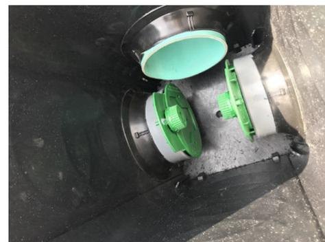
Emboîter les égalisateurs dans les manchons à l'intérieur du regard. Ajuster les égalisateurs à l'aide des molettes de façon à ce que les vannes soient en position haute.
