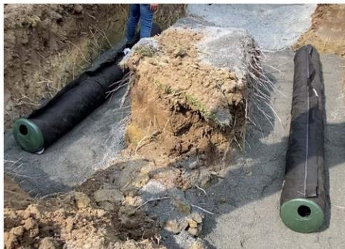
Préparer les tranchées selon les plans puis déposer 15 cm de sable filtrant de niveau.
