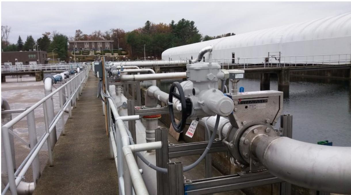
*Vanne de régulation à diaphragme Iris® avec mesure du débit massique à la station d'épuration d'Upper Blackstone*
