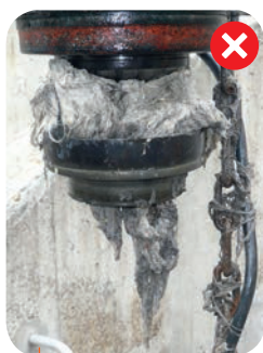
Pompes de relevage obturées
