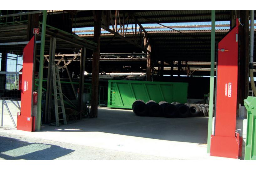
Ces barrières manuelles certifiées TUV et V.d.S. sont situées à <u>chaque côté</u> de l'ouverture. Les barrières doivent être manuellement pivotées de la verticale à l'horizontale. Elles se rejoignent au centre de l'ouverture et sont fermées à l'aide d'un tendeur.
