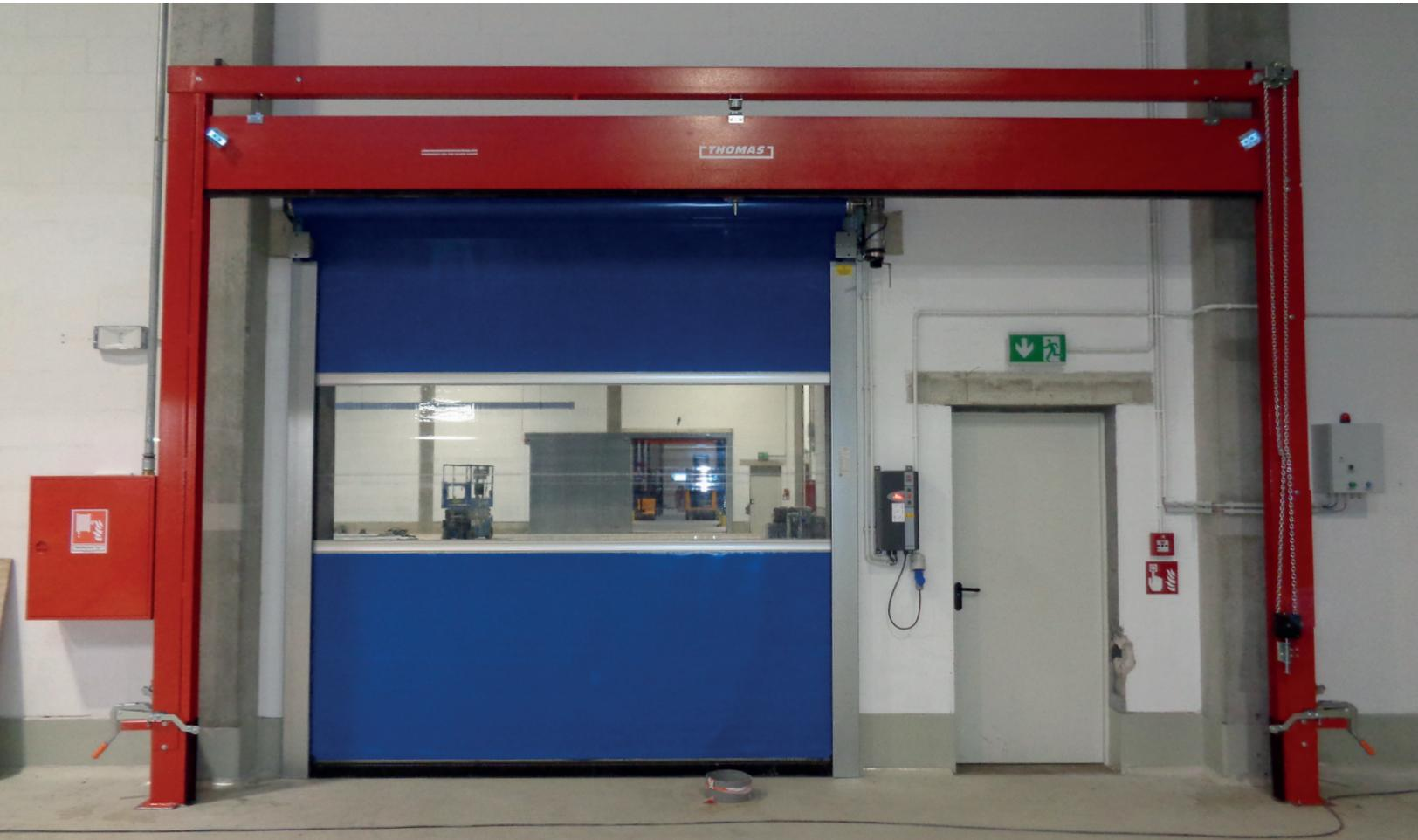
Cette barrière de rétention semi-automatique certifiée TUV et V.d.S. est située au-dessus de l'ouverture, maintenu par un électro-aimant.
