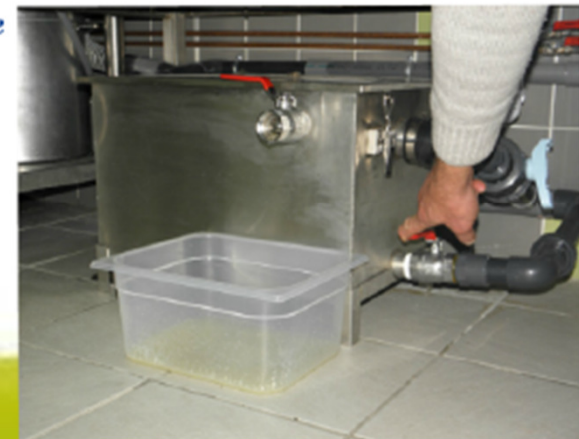
6 : ouvrir 1 min la vanne de vidange pour évacuer les résidus du fond
